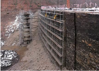
Obr. 13., 14.: Průběh rekonstrukce VD Jezeří – odstraněná koruna hráze a návodní líc až na rybný těsnící vrstvy, rekonstrukce manipulační věže jejím přezděním, 2022-24. Průběh rekonstrukce VD Harcov – odstraněná koruna hráze a předsyp, úprava oken korunového přelivu, přebetonování štol spodních výpustí a dobudování injekční štol (zdroj: M. Strnadová, J. Pešek, MF Dnes)
