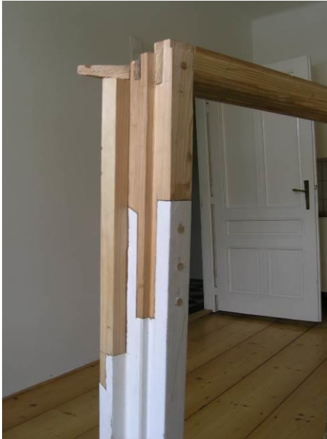
Obr. 4 Doplnění poškozených částí, vč. klapačky a okapnice. Původní dřevo v místě napojení je zcela zdravé. (foto Matěj Boháč)
