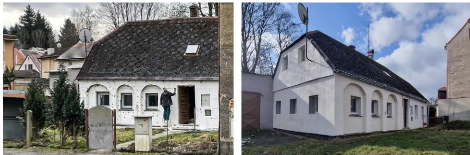
Obr. 6.: Příklady soudobých intervencí u podstávkového domu – Zateplování Vlevo – Vodní 936/6, Rumburk – 2023 / Šluknovsko/ (Autor: Osobní archiv pana Ondřeje Uhera) Vpravo – Vodní 936/6, Rumburk – 2024 / Šluknovsko/ (foto S. Kutílková)
