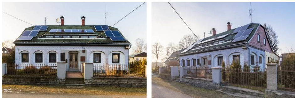
Obr. 12.: Příklad užití fotovoltaických panelů na podstávkovém domě Staré Křečany č.p. 424 /Šluknovsko/ (foto S. Kutílková; 2024)
