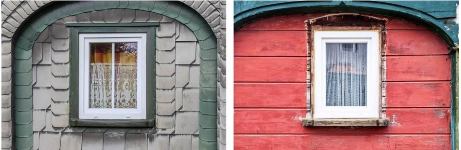
Obr. 14.: Detail osazení plastových oken ve stěnách podstávkového domu Vlevo – Brtníky č.p. 30 /Šluknovsko/ Vpravo – Mikulášovice č.p. 212 /Šluknovsko/ (foto S. Kutílková; 2017-2024)
