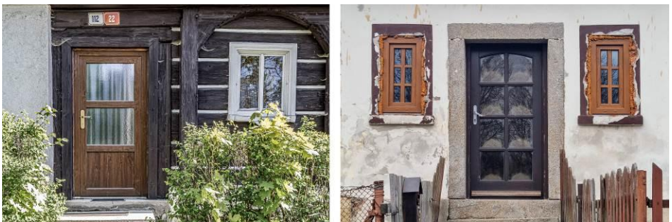
Obr. 15.: Detail osazení novodobých dveří ve stěnách podstávkového domu Vlevo – Brtníky č.p. 112 /Šluknovsko/ Vpravo – Rolnická č.p. 188/13 č.p., Rumburk /Šluknovsko/ (foto S. Kutílková; 2024)
