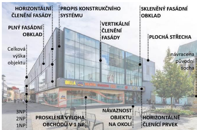
Obr. 9.: Rozbor nového výrazu OG Zlatá brána po rekonstrukci
