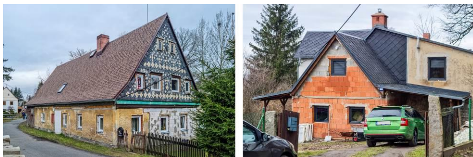
Obr. 9.: Příkladny necitlivých soudobých intervencí u podstávkového domu Vlevo – Mikulášovice č.p. 354 /Šluknovsko/ Vpravo – Mikulášovice č.p. 600 /Šluknovsko/ (foto S. Kutílková; 2024)
