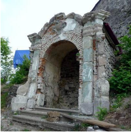
Obr. 4 Kaplnka Kalvárie pred reštaurovaním, poškodená v dôsledku použitia netradičných technológií pri oprave.
