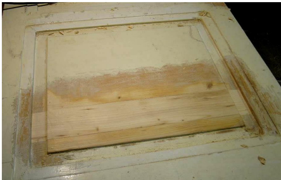
Obr.7 Oprava kazety vsazením nového dřeva v celé šířce. (foto Matěj Boháč)
