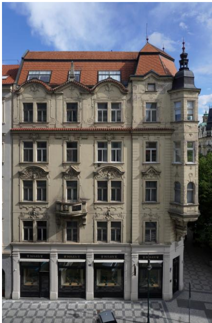
Obr. 1 Průčelí reprezentativního činžovního domu v Praze – Pařížské ulici, 1905 (foto Matěj Boháč).
