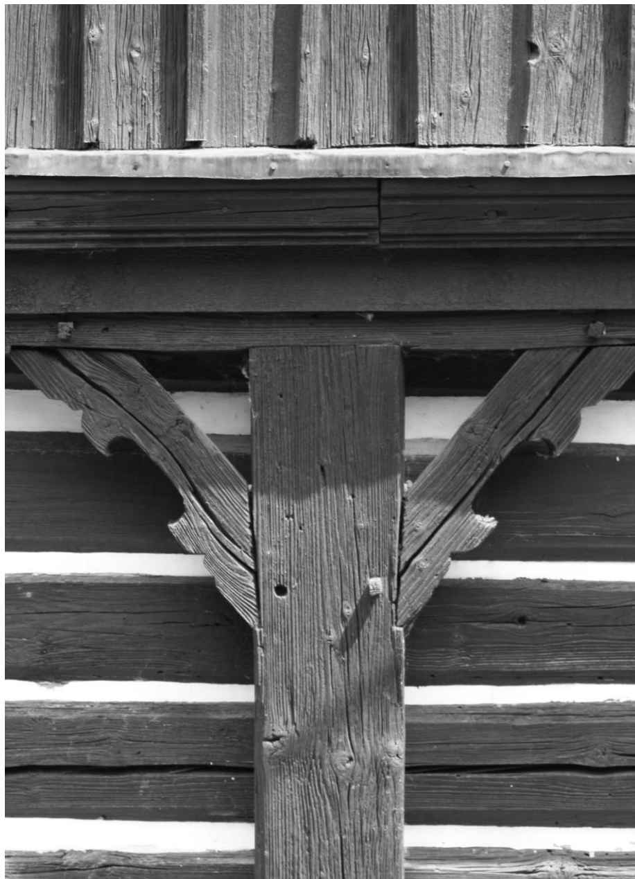
Detail podstávkové konstrukce (Valkeřice, foto Klára Kroftová)
