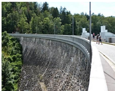
Obr. 11., 12.: Příklad urovnění zdiva – Harcov řádkové, Seč kyklopské (zdroj: autor).
