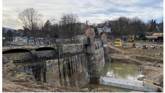
Obr. 13., 14.: Průběh rekonstrukce VD Jezeří – odstraněná koruna hráze a návodní líc až na rybný těsnící vrstvy, rekonstrukce manipulační věže jejím přezděním, 2022-24. Průběh rekonstrukce VD Harcov – odstraněná koruna hráze a předsyp, úprava oken korunového přelivu, přebetonování štol spodních výpustí a dobudování injekční štol (zdroj: M. Strnadová, J. Pešek, MF Dnes)
