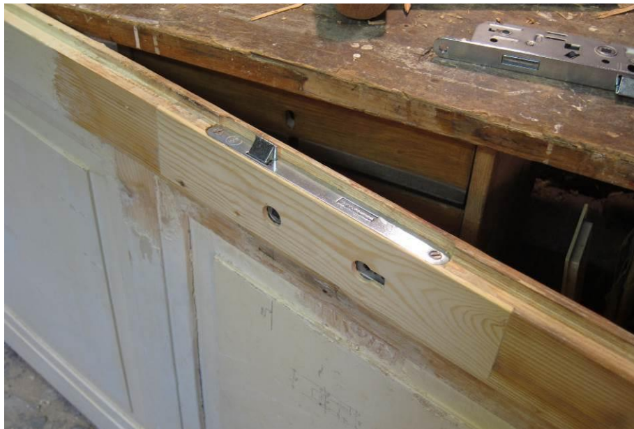
Obr. 8 Oprava v místě osazení zadlabacího zámku. (foto Matěj Boháč)
