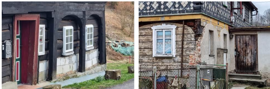
Obr. 5.: Příklady soudobých intervencí u podstávkového domu – vyzdění Vlevo – příklad necitlivé intervence – Dlouhý Důl č.p. 26 /Šluknovsko/ Vpravo – příklad necitlivé intervence – Mikulášovice č.p. 354 /Šluknovsko/ (foto S. Kutílková; 2024)
