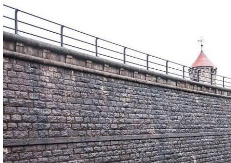
Obr. 11., 12.: Příklad urovnění zdiva – Harcov řádkové, Seč kyklopské (zdroj: autor).
