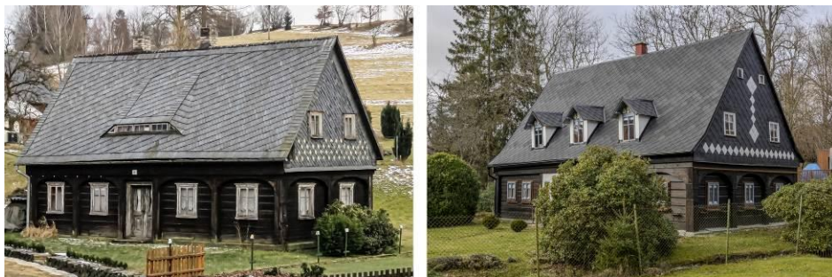
Obr. 11.: Příklady pokládky střešní krytiny (foto S. Kutílková; 2024)
