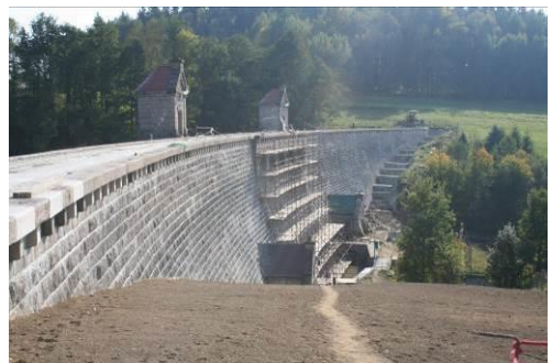
Obr. 15., 16.: Přelití koruny hráze v roce 2010 při přívalové povodni (zdroj: Povodí Labe, s.p.). Zabezpečení a rekonstrukce hráze Mlýnice, přetěsnění koruny hráze, zabezpečení vzdušní paty proti účinkům přelití (Zdroj: autor).
