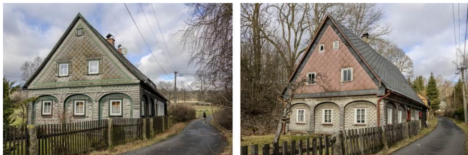
Obr. 7.: Příklady soudobých intervencí u podstávkového domu – Obložení podstávkové konstrukce
