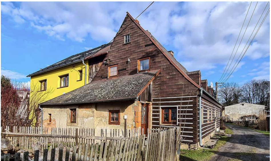
Obr. 2.: Příklad soudobé necitlivé intervence u podstávkového domu – Vilémov č.p. 211 /Šluknovsko/ (foto S. Kutílková; 2022)
