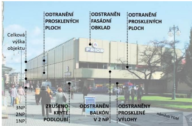
Obr. 8.: Popis stavebních úprav provedených při rekonstrukci
