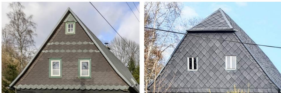
Obr. 13.: Příklady obložení štítů na podstávkovém domě Vlevo – Asfaltová šindel – Brtníky č.p. 53 /Šluknovsko/ Vpravo – Šablony z recyklovaného plastu – Vilémov č.p. 68 /Šluknovsko/ (foto S. Kutilková; 2022-2024)
