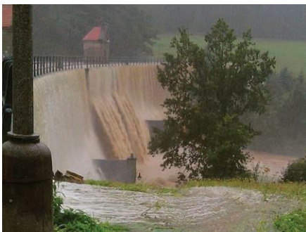
Obr. 15., 16.: Přelití koruny hráze v roce 2010 při přívalové povodni (zdroj: Povodí Labe, s.p.). Zabezpečení a rekonstrukce hráze Mlýnice, přetěsnění koruny hráze, zabezpečení vzdušní paty proti účinkům přelití (Zdroj: autor).
